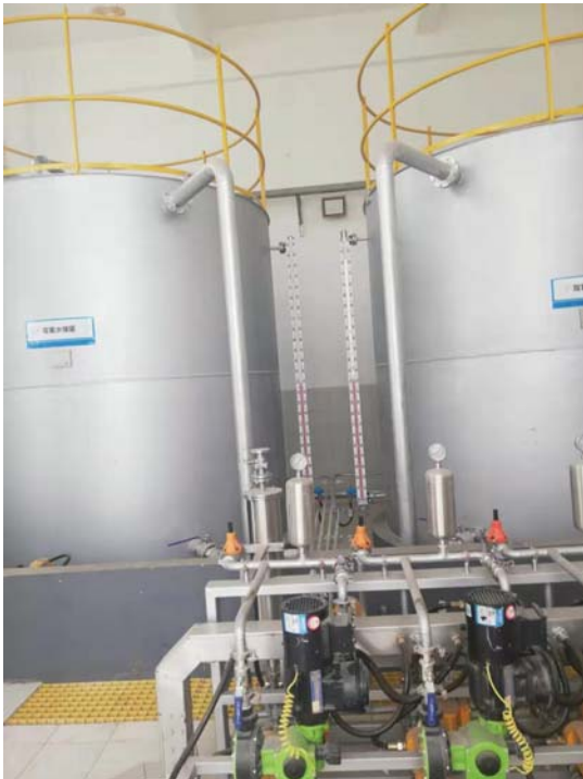
双氧水储罐及围堰
