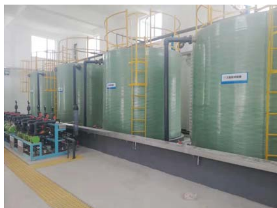
次氯酸钠储罐及围堰
