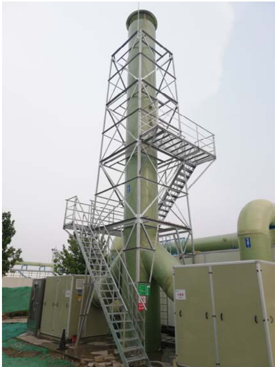
排气筒及采样平台
