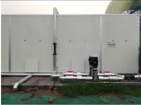
除臭净化装置
