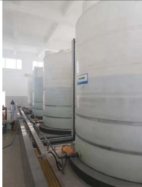
氢氧化钠储罐及围堰
