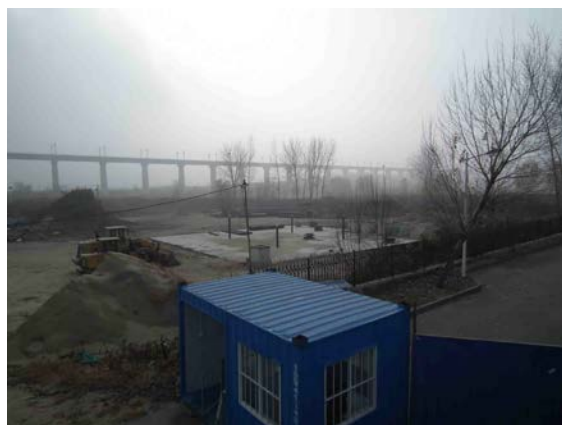
建设中的尾水排放泵房 (为尾水排放管道工程项目内容)
