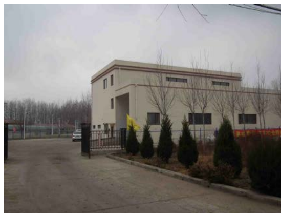
东侧：垃圾转运站
