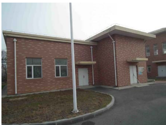
粗格栅及提升泵房
