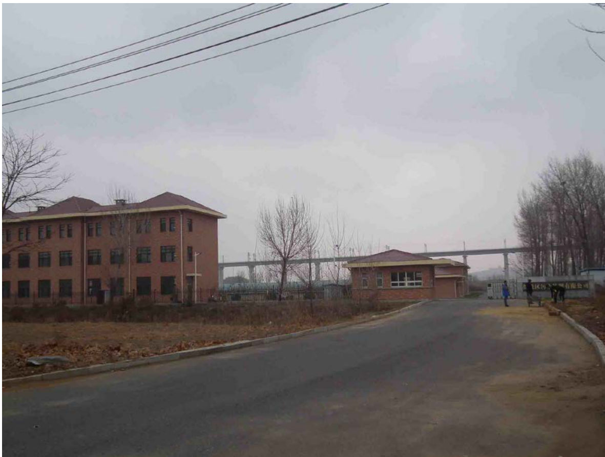
大连保税区亮甲店污水处理厂（一期）工程全景
