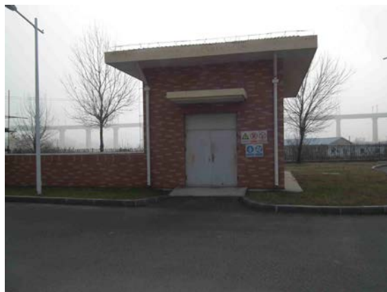
除臭间（生物除臭滤池）
