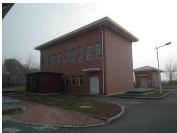
细格栅及曝气沉砂池
