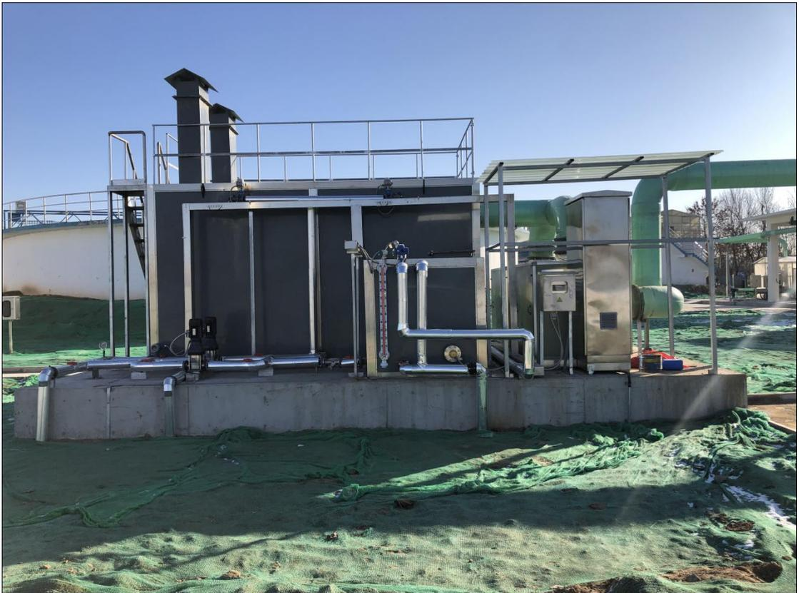
图 4.1-1 生物滤池除臭装置
