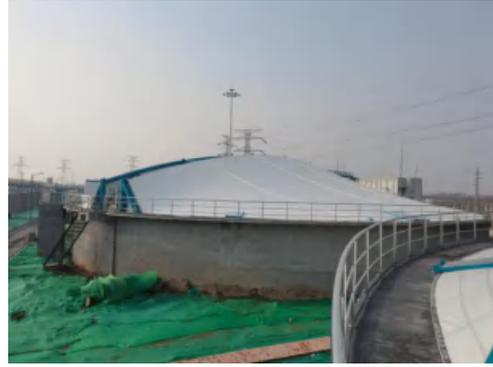
图 4-4 初沉池废气收集
