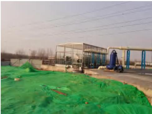
图 4-1 粗格栅及进水泵房废气收集
