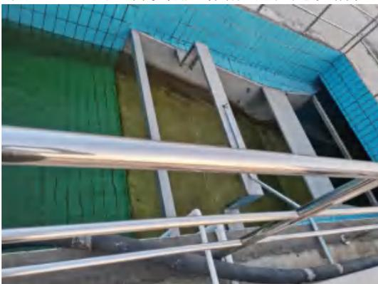
图 4-30 废水尾水测流槽
