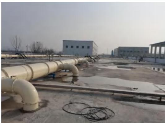
图 4-7 多级 AO 生物反应池废气收集
