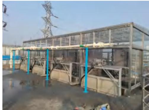
图 4-2 细格栅废气收集
