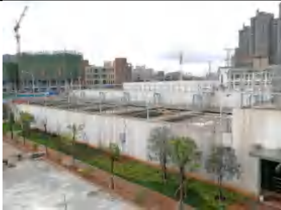
曝气硝化生物滤池
