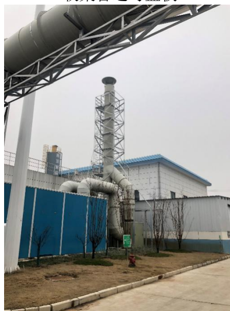
2#生物滤池及排气筒
