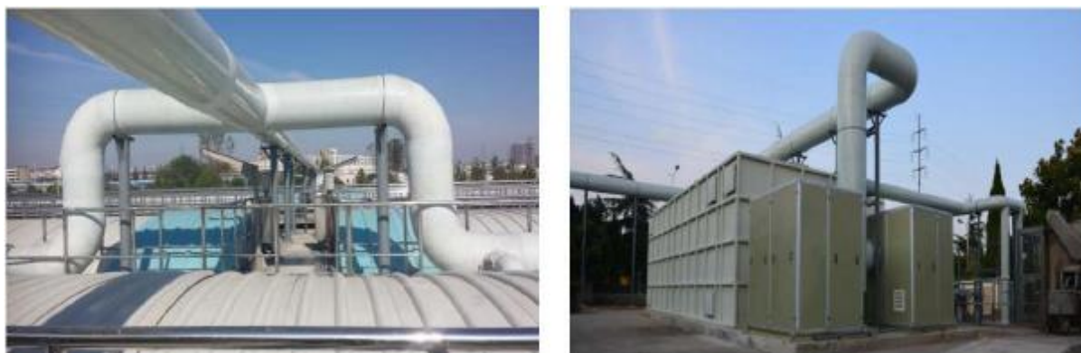
4.3-4 废气处理收集及处理系统
