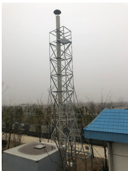
1#生物滤池及排气筒
