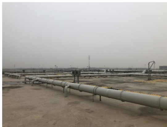
收集管道与盖板
