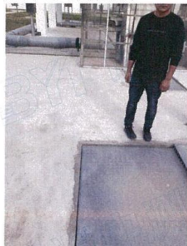
★生活废水进口
