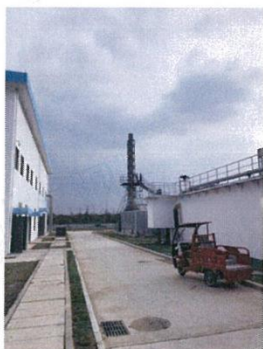
◎生物除臭装置排气筒
