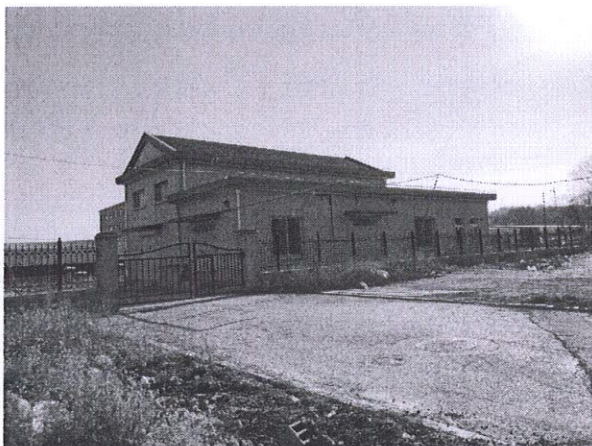
厂区东南侧大连中水回用泵站
