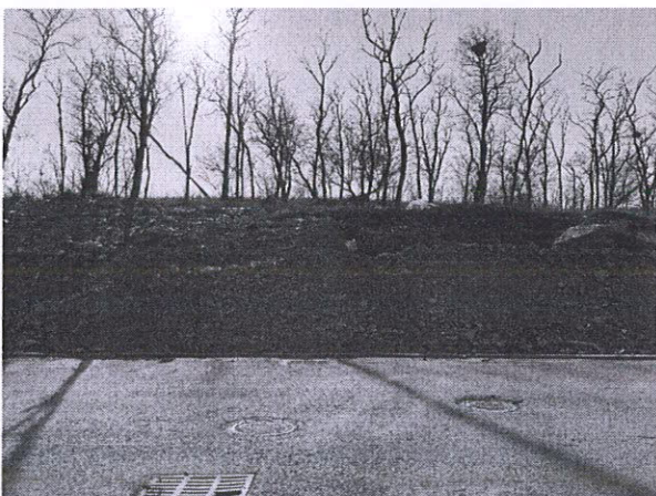
厂区南侧土山
