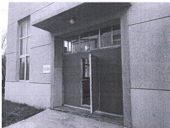
污水提升泵房
